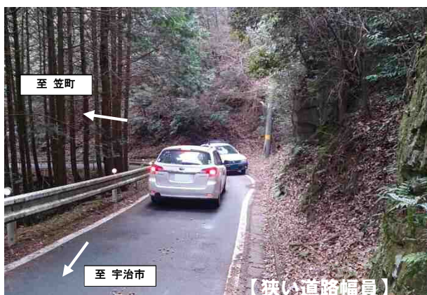
写真-1 現道の状況 (幅員狭小)
