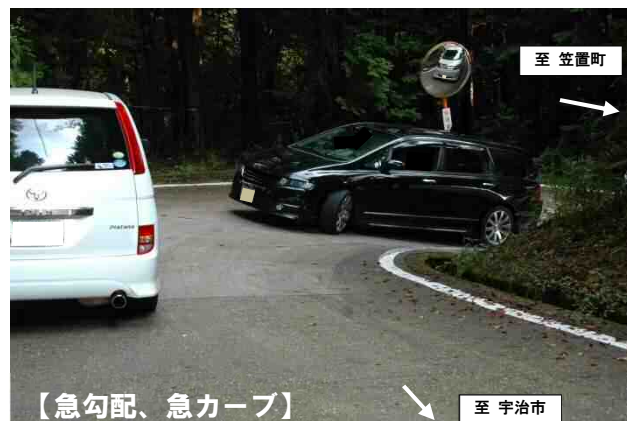
写真-2 現道の状況 (急カーブ・急勾配)
