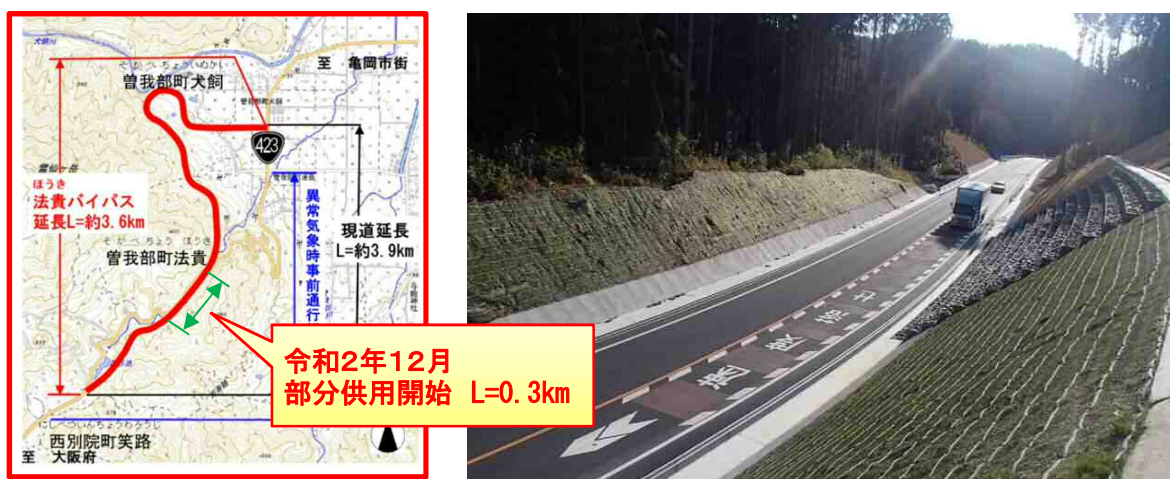
図-13 部分供用の状況
