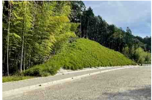
図-25 他事業での在来種による法面緑化事例
