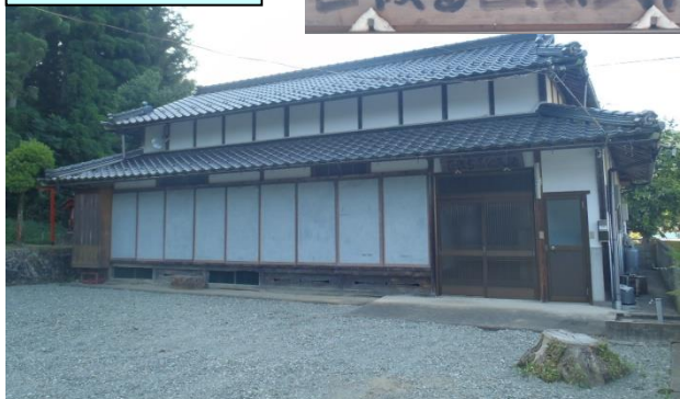
保全対象 (正後寺公民館)
