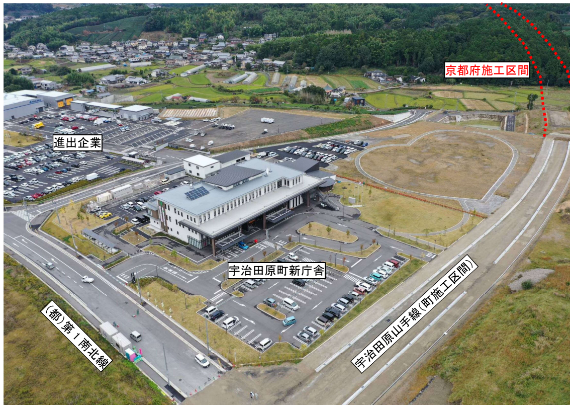
写真-4 新庁舎及び周辺の開発状況
