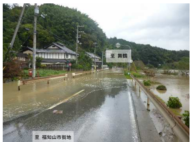
(道路冠水状況 (平成 29 年 10 月))
