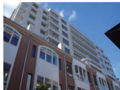
＜高松市丸亀町商店街のまちづくり＞ 街なか居住の推進 西館マンション
