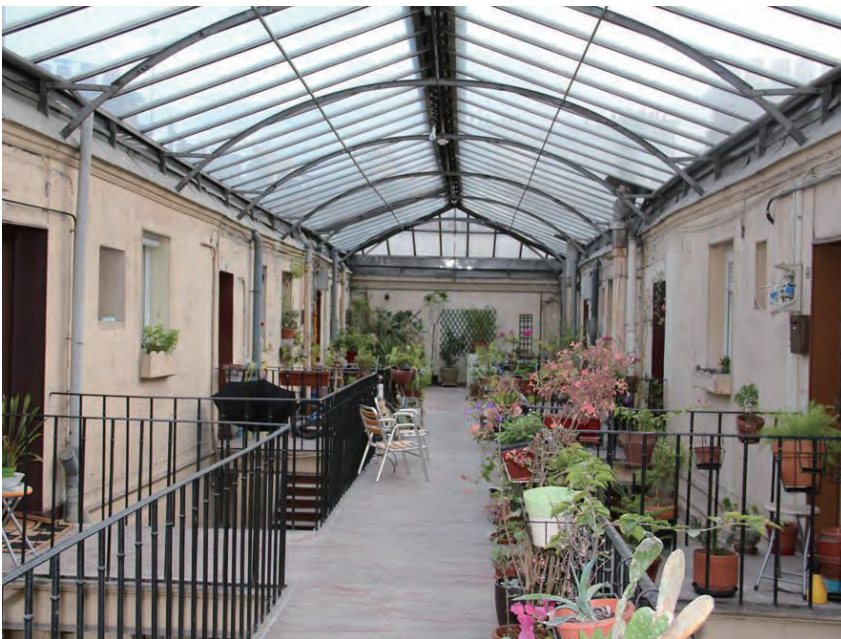
1853年ナポレオン3世統治期に建設された集合住宅
