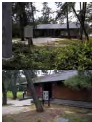
周辺景観に配慮して建てられたトイレ
