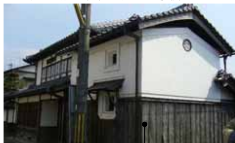
外壁に焼き杉板を用いた事例
