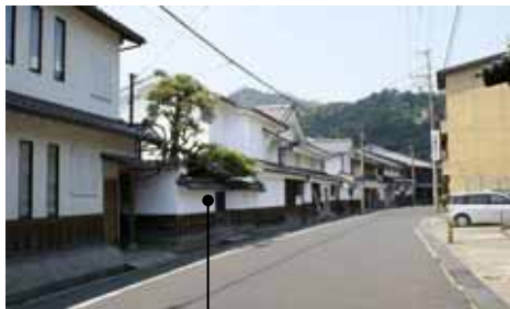
外壁に白漆喰を用いた事例
