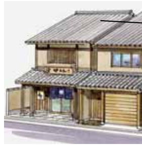
和瓦の勾配屋根の例
