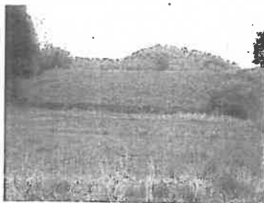
ため池下流側法面
