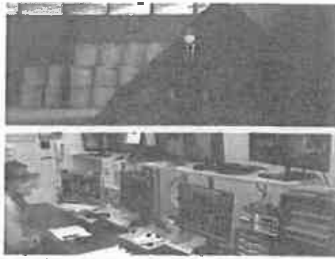
林ペニヤ舞鶴バイオ発電所
