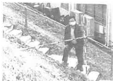
危険な井川川堤防調査
