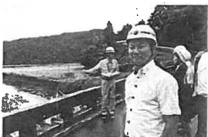
危機管理・建設交通常任委員会で、丹後：国道178号・筒川等の災害現場を視察し災害復旧事業の状況を確認しました。
