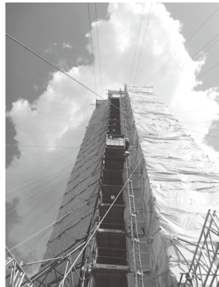
修復中のキューパゴダ
