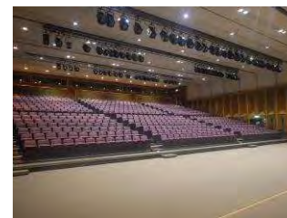
(1) 京都テルサ(特定天井改修)
