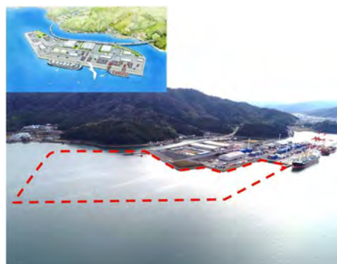
舞鶴国際ふ頭Ⅱ期整備
