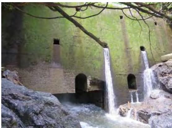
灰屋川（京都市右京区） 砂防えん堤修繕
