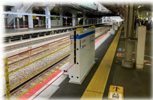
鉄道駅舎バリアフリー化設備整備事業 (JR京都駅ホーム柵整備)
