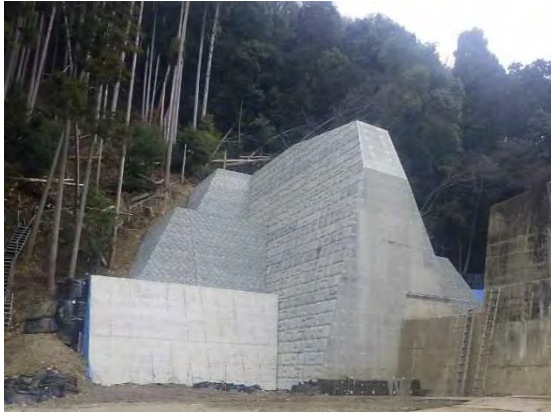
北川（京都市西京区）えん堤
