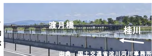
桂川嵐山地区左岸溢水対策(可動式止水壁)
