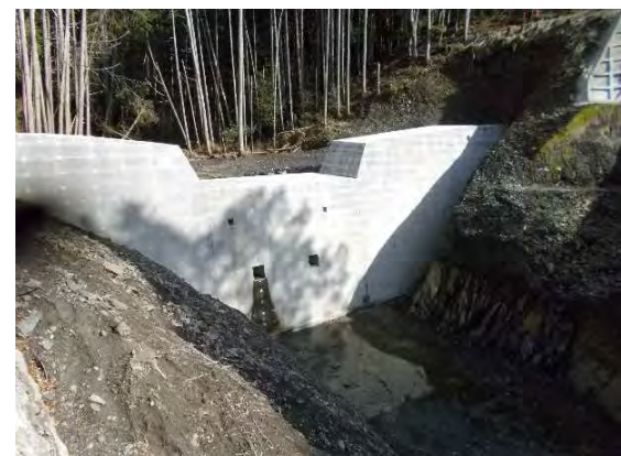
門前川（和東町）砂防えん堤
