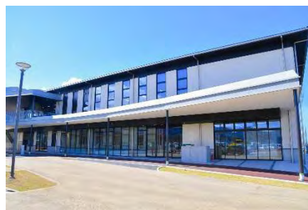
綾部中心市街地地区都市構造再編集中事業（施行中） （綾部市 駅北複合施設（子育て交流センター等））
