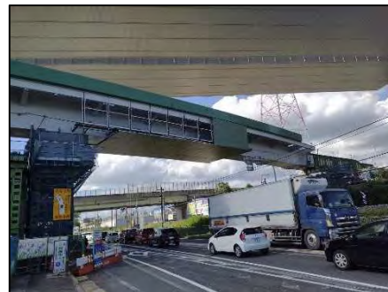
山城総合運動公園城陽線 (城陽橋)
