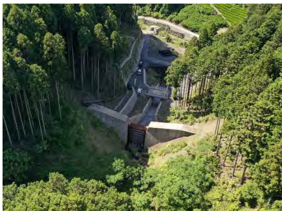
中ノ谷川（宇治田原町）砂防えん堤
