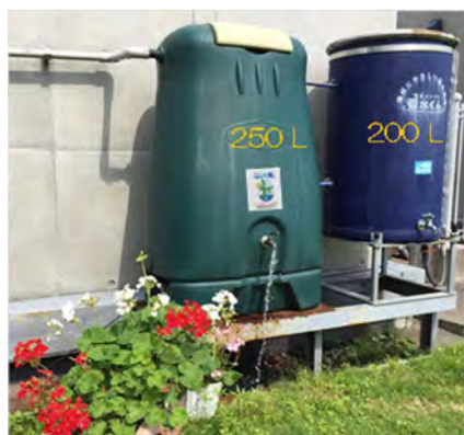
設置例 1 (府庁2号館屋上)
