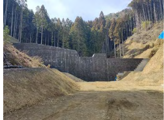
蛙ヶ谷川（京都市北区）砂防えん堤
