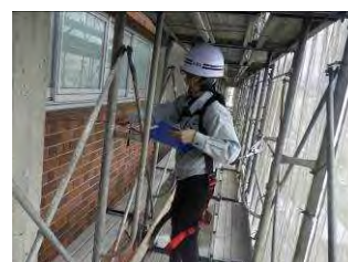
(5) 工事監理(外壁補修検査)
