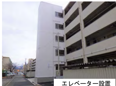
エレベーター設置
