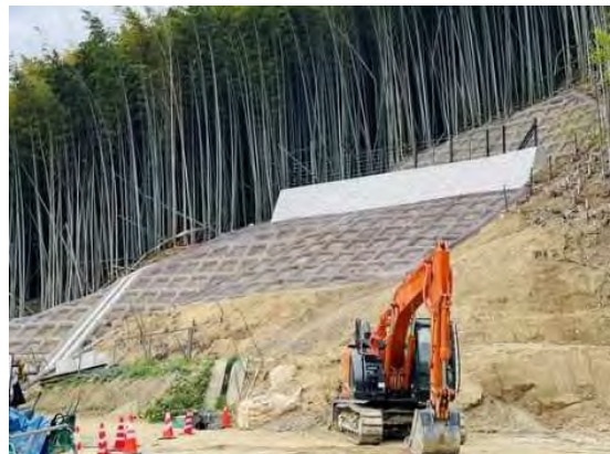
早稲田（大山崎町） 法枠工
