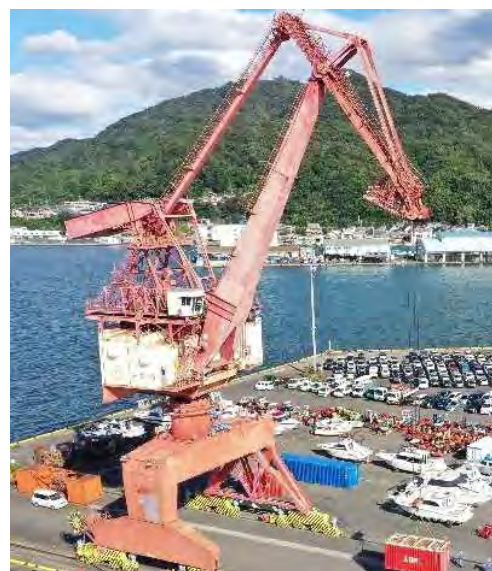
第2ふ頭の老朽化した多目的クレーンの更新
