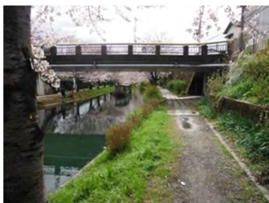
伏見港の園路再整備
