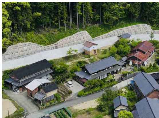
本庄上（伊根町） 擁壁工
