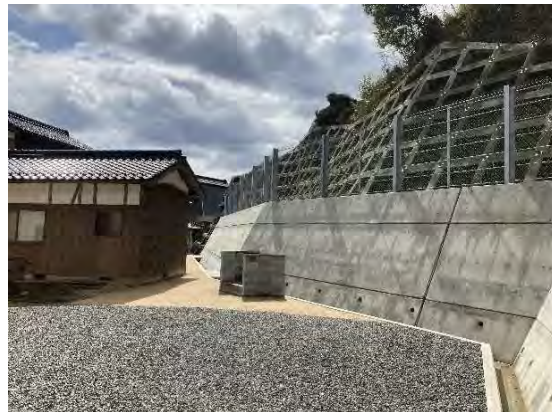
志高（舞鶴市） 擁壁工
