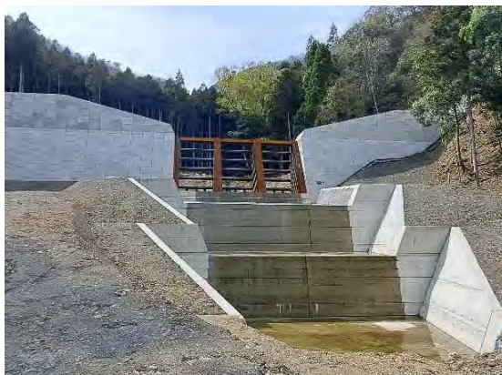
篠原西一谷川（京丹波町）砂防えん堤
