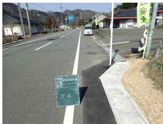
完成 (側溝蓋の設置)
