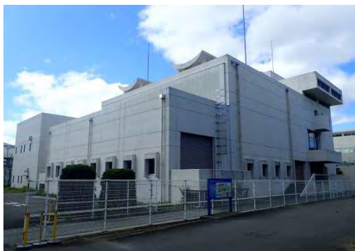
送風機棟（耐震補強）
