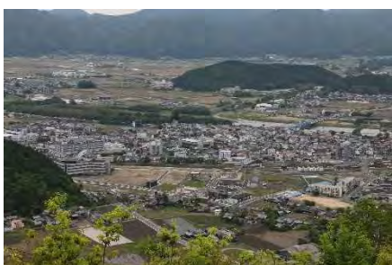
八木駅西地区土地区画整理事業（施行中） （南丹市〔組合施行〕）
