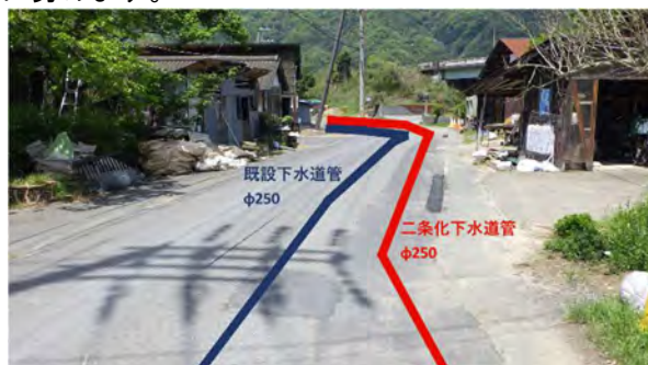
二条管増設箇所
