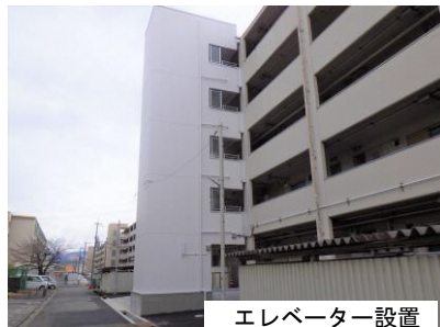
エレベーター設置
