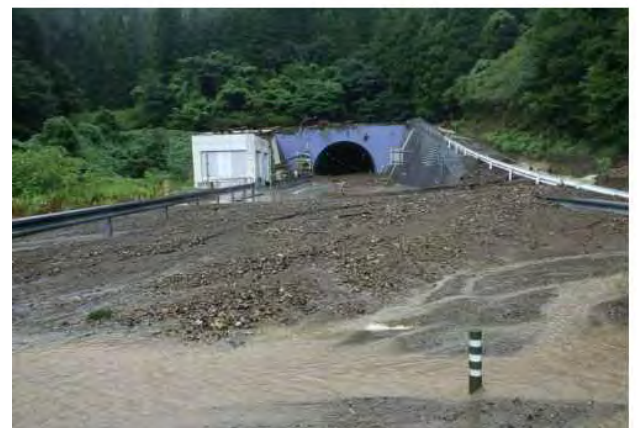
京都縦貫自動車道 坊口トンネル（綾部市）
