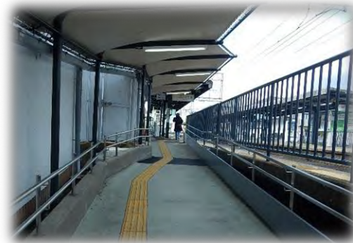
鉄道駅舎バリアフリー化設備整備事業 (近鉄山田川駅下りスロープ整備)
