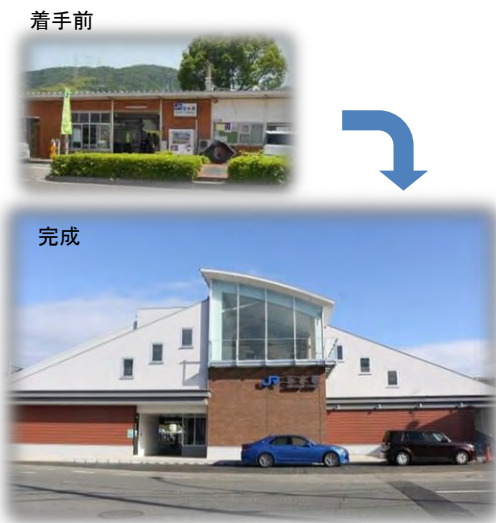
JR奈良線玉水駅橋上化 (平成30年度開業)
