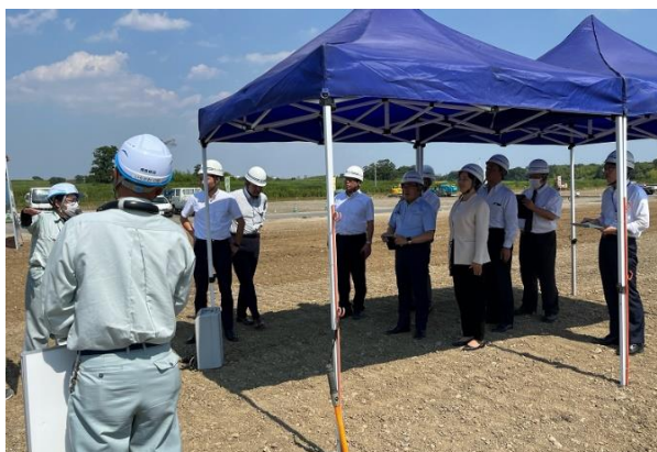
工事現場を視察
