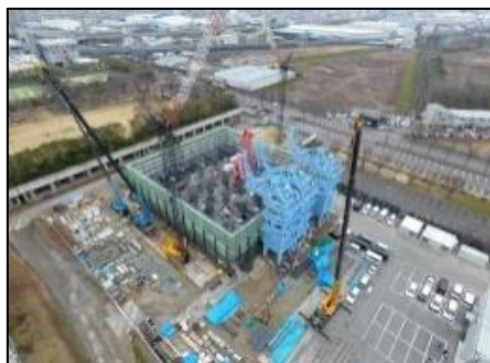
建設中の呑龍ポンプ場
