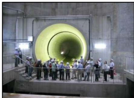
乙訓ポンプ場 北幹線3号管渠（供用中） （乙訓ポンプ場から管渠を眺む）
