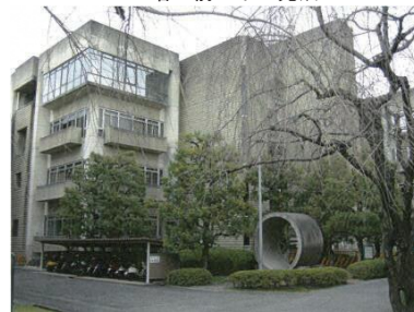
洛西浄化センター管理棟(南館)耐震化工事 上：着工前 下：完成
