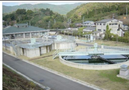
和東町 和東中央浄化センター
