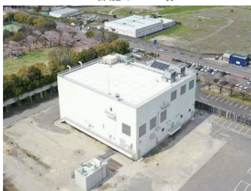
呑龍ポンプ場
