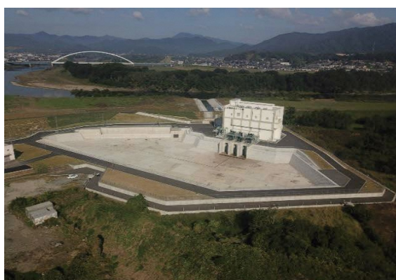
福知山市 段畑雨水ポンプ場
