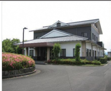
綾部市 綾部浄化センター
