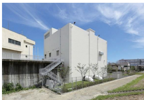
大山崎町 大山崎排水ポンプ場
