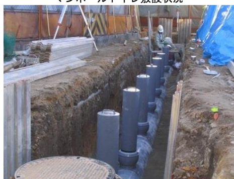
マンホールトイレ敷設状況
