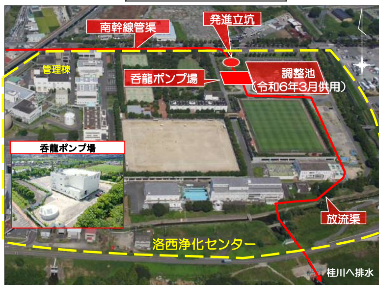
洛西浄化センター 上空写真
