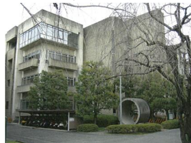
洛西浄化センター管理棟(南館)耐震化工事 上：着工前 下：完成
