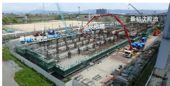
洛南水処理施設E1系増設工事（R3年5月時点）
