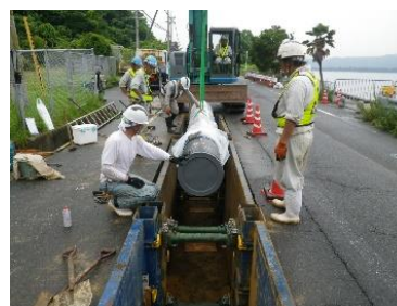
宮津湾流域 二条化工事
