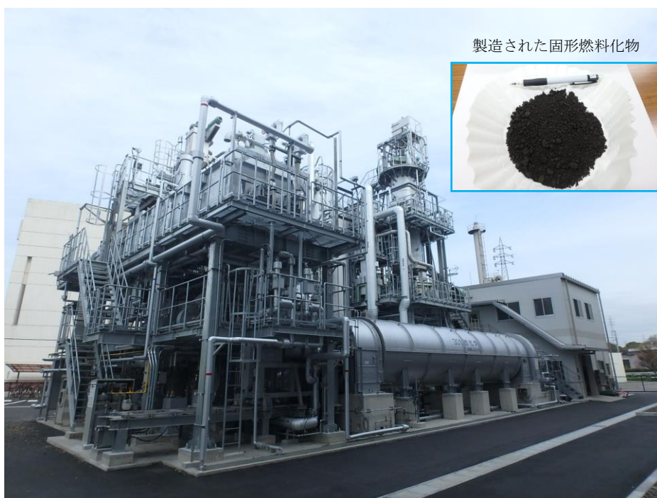
下水汚泥固形燃料化施設
