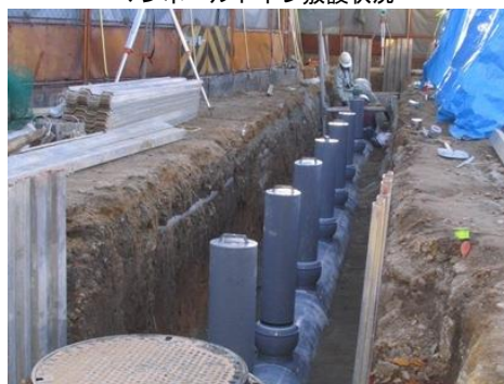
マンホールトイレ敷設状況
