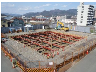
写真-2：工事の様子
