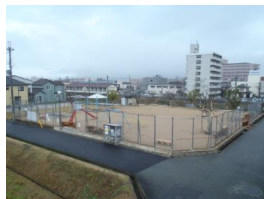
写真-3：公園リニューアル工事
