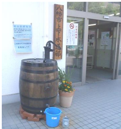
雨水貯留施設（八幡市上下水道部）
