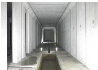
写真-1：貯留施設内部
