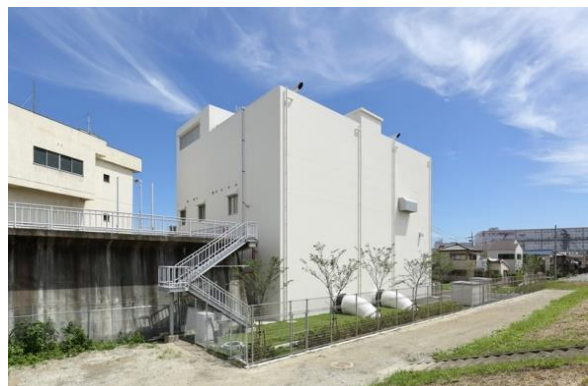
大山崎町 大山崎排水ポンプ場
