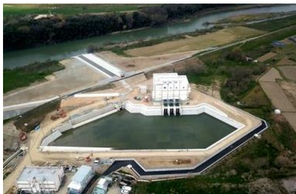
福知山市 段畑雨水ポンプ場
