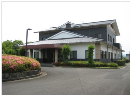
綾部市 綾部浄化センター
