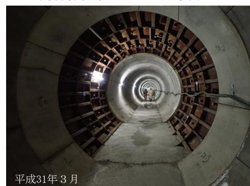
南幹線管渠シールド工事完成
