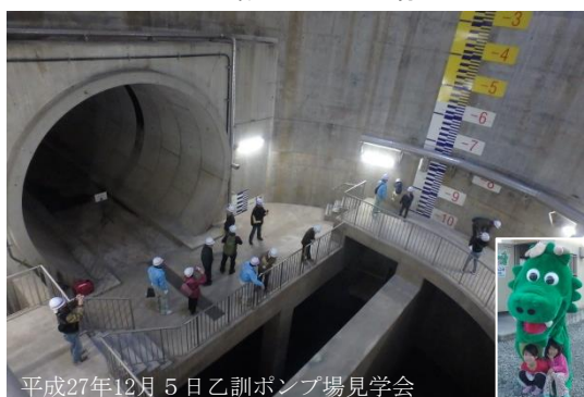
乙訓ポンプ場
