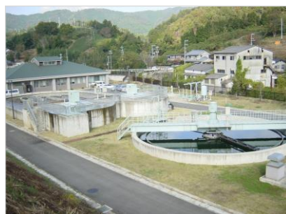
和束町 和束中央浄化センター
