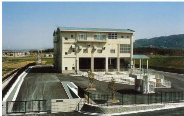
精華町 下狛ポンプ場
