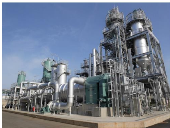
固形燃料化施設全景
