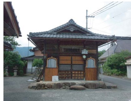
写真7 長尾薬師堂（福知山市） 屋根葺替修理
