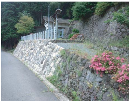
写真6 古岩神社（京丹波町） 防災道路（参道）修理
