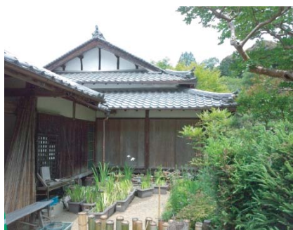
写真1 浄瑠璃寺大日堂（木津川市） 部分修理（アライグマ対策等）
