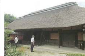
写真③ 伊佐家住宅・主屋(八幡市) (重要文化財・屋根等修理)
