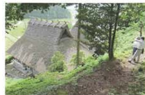
写真④ 深見寺・庫裏(南丹市) (未指定文化財・屋根修理)
