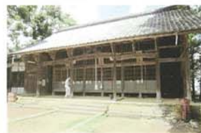
写真⑦ 圓隆寺・愛宕堂(舞鶴市) (未指定文化財・屋根修理)
