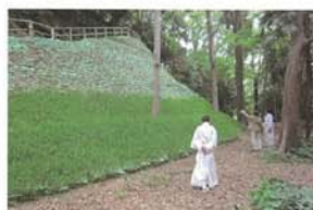
写真⑯ 石清水八幡宮 境内 (国史跡・災害復旧事業)
