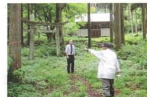
写真⑨ 寺領観音堂(伊根町) (未指定文化財・保存修理)
