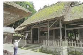
写真⑤ 摩気神社・本殿覆屋(南丹市) (府指定文化財・屋根修理)
