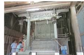
写真⑥ 熊野神社・本殿(舞鶴市) (未指定文化財・保存修理)
