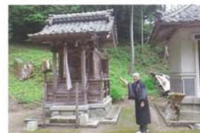
写真⑧ 常德寺・三十三番神堂(京丹後市) (未指定文化財・屋根修理)
