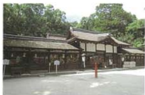
写真⑩ 賀茂御祖神社・河合神社(上京区) (未指定文化財・防災・防犯設備)
