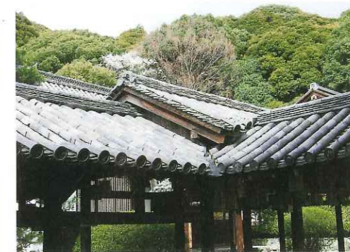
写真2 萬福寺（宇治市） 重要文化財・大雄宝殿の回廊屋根修理
