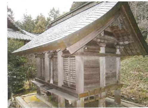
写真4 石田神社（綾部市） 重要文化財・恵比須神社本殿の壁板のアライグマ被害修理
