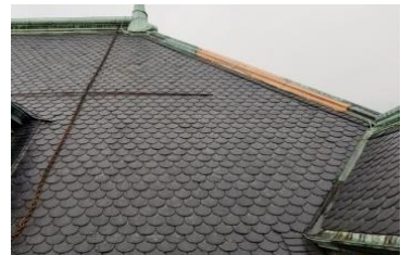
屋根（南東隅）の修理
