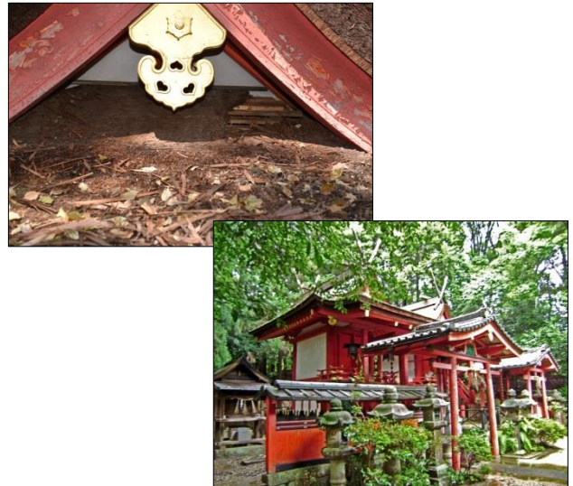
写真2 重要文化財・松尾神社本殿 (木津川市) 檜皮屋根修理（アライグマ被害）
