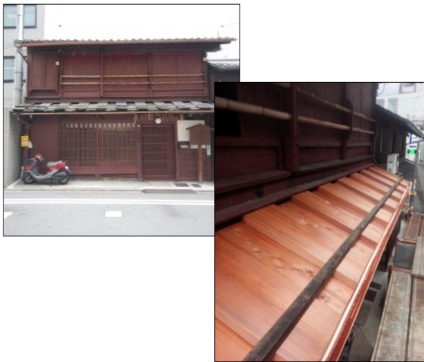
写真1 京都市指定 小結棚町会所 (中京区) 庇修理
