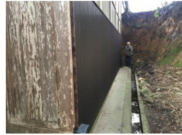
<雪囲い設置後>
