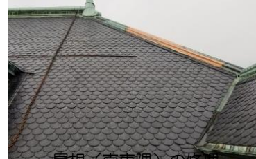
屋根（南東隅）の修理
