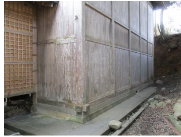
<雪囲い設置前>
