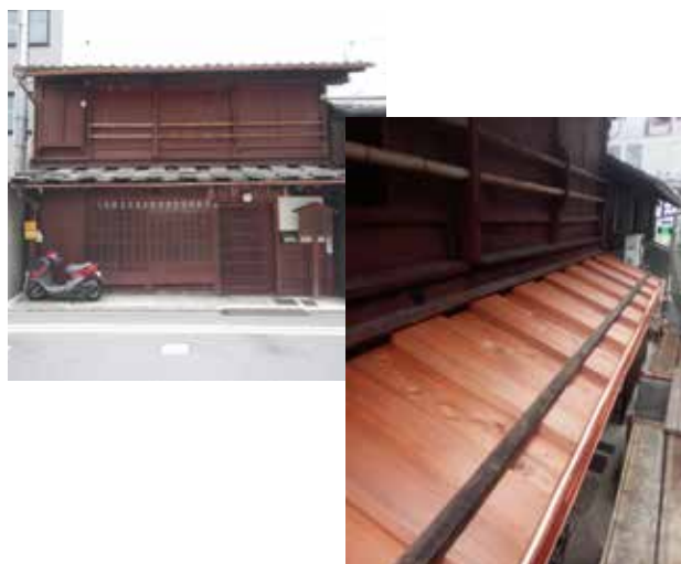
写真1 京都市指定 小結棚町会所 (中京区) 庇修理
