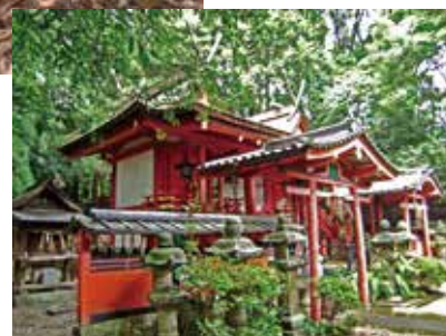
写真2 重要文化財・松尾神社本殿 (木津川市) 檜皮屋根修理（アライグマ被害）
