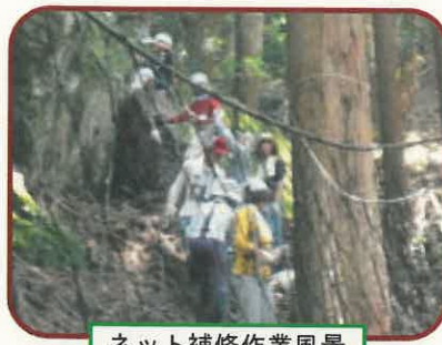
ネット補修作業風景
