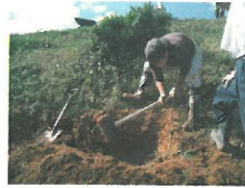
転圧 掛矢で突き固めます
