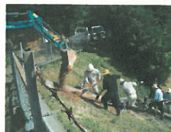
改良土運搬 波板シュートで
