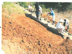
掘削整地完了
