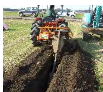
暗渠排水の整備
