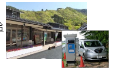
EV車等への給電設備
