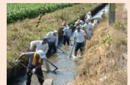
水路の泥上げ
