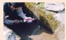
水路のひび割れ補修
