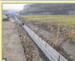
用水路の改修
