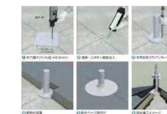
ソーラーパネルの基礎
