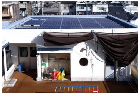
図8 市民協働により太陽光発電設備・蓄電池の導入による防災力向上を図る府内の施設
