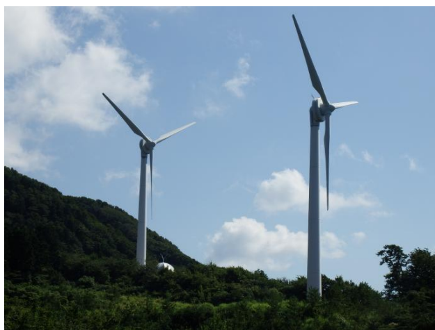
図4 風力発電導入の先駆けとなった太鼓山風力発電所
