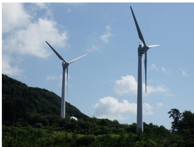
図４ 風力発電導入の先駆けとなった太鼓山風力発電所
