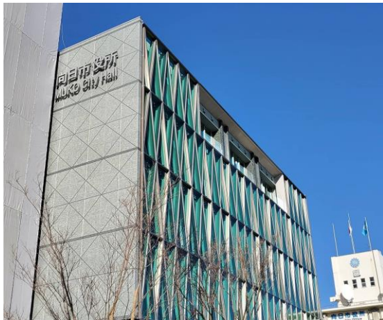
2021年に竣工した向日市新庁舎（ZEB Ready）
