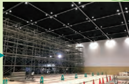
ホール内 天井仕上げ 作業中
