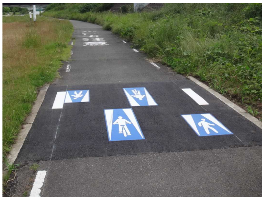
自転車通行位置の明示の例 (石川リバーサイドサイクルライン)
