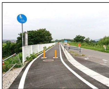
一般府道京都八幡木津自転車道線 （木津川市）
