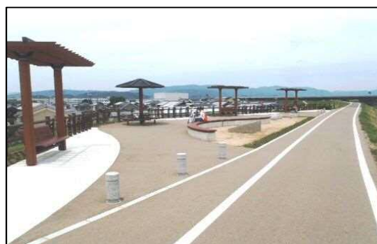
一般府道京都八幡木津自転車道線 休憩施設（茶いくるスポット）の整備
