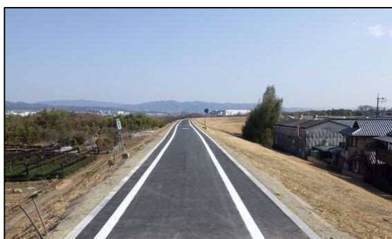
一般府道京都八幡木津自転車道線 大規模自転車道のリニューアル
