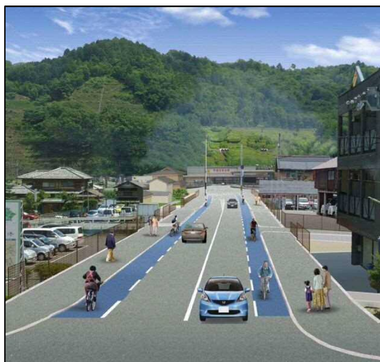
無電柱化による歩行者と自転車の 通行空間を確保 一般府道園部停車場線（園部駅前） （完成予想図）
