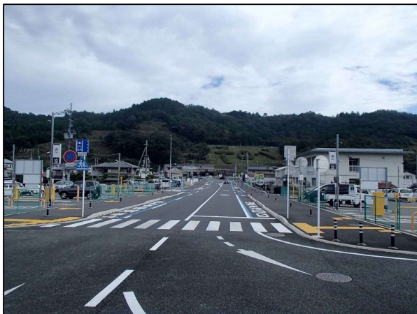
無電柱化による歩行者と自転車の通行空間の確保 一般府道園部停車場線（園部駅前）
