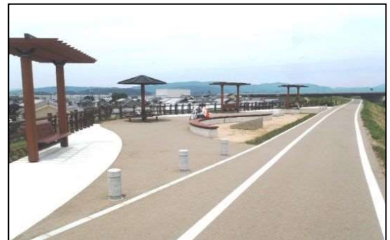
一般府道京都八幡木津自転車道線 休憩施設（茶いくるスポット）の整備
